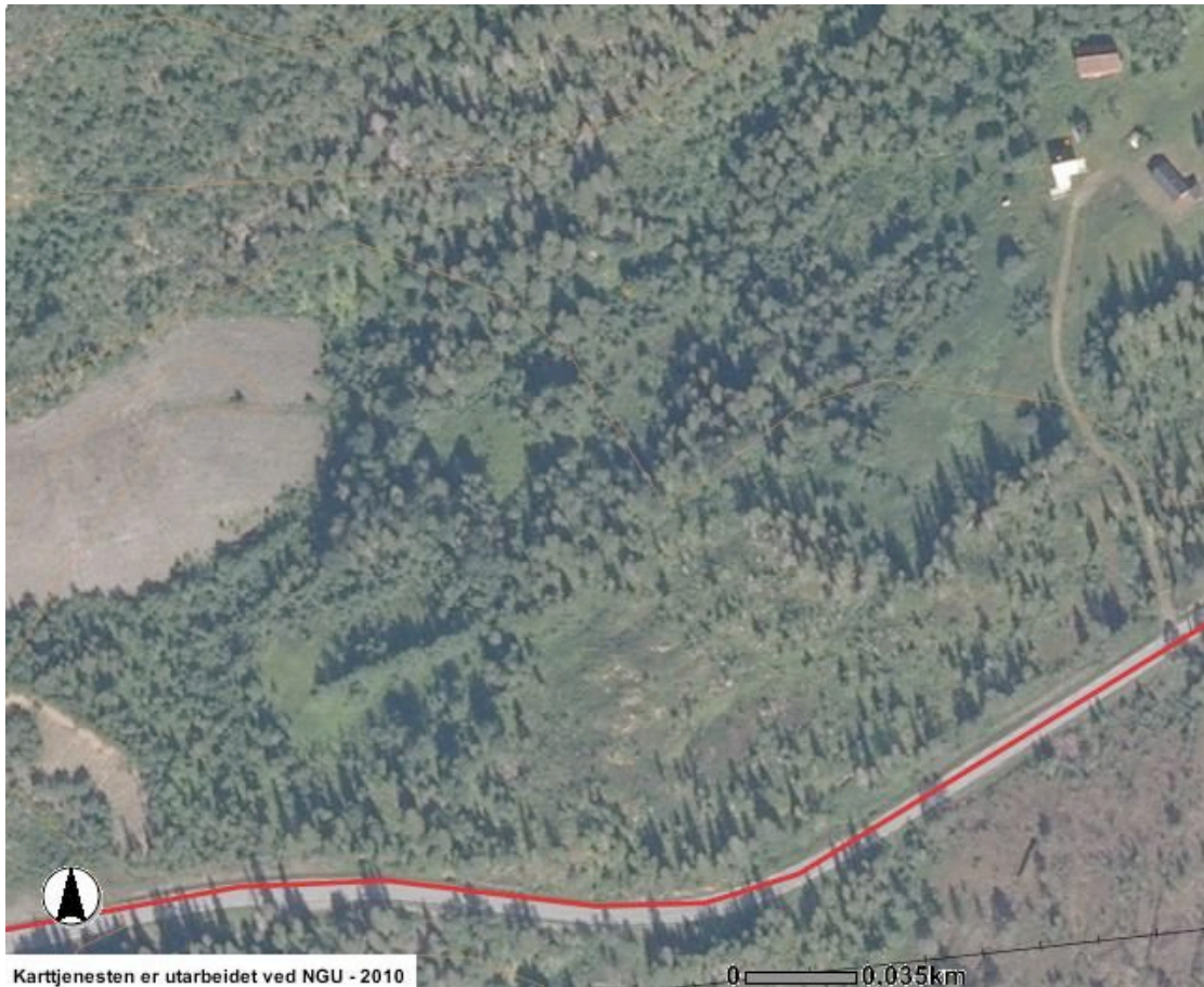
Figur 3. Oversiktsbilde av tiltaksområdet, som strekker seg fra det eksisterende massedeponiet (grått åpent felt i venstre del av bildet) bort til den nedlagte gården på Almhaugen i høyre bildekant. I sør utgjør E6 grensen for det planlagte tiltaksområdet.
